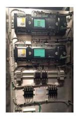
The BFM-II está idealmente diseñado para actualizar las subestaciones existentes con relés electromecánicos
